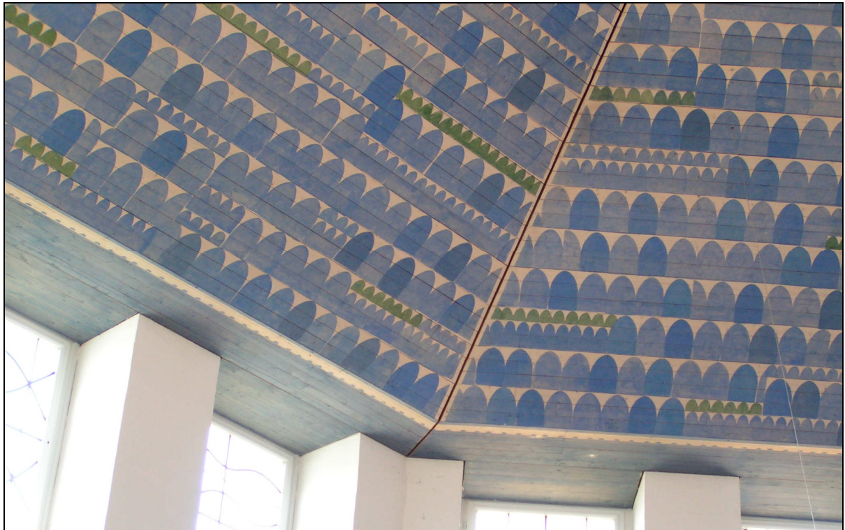
Abbildung 9: Untersicht der Holzdecke
